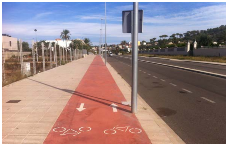
Carril bici Calle Polígono 61
